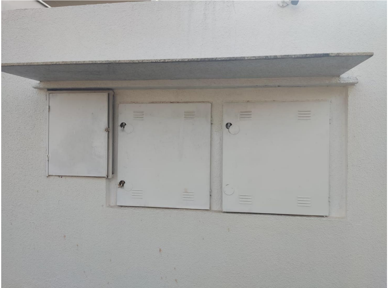
FIGURA 4 (PADRÃO DE ENTRADA MEDIÇÃO INDIRETA GRUPO A)
