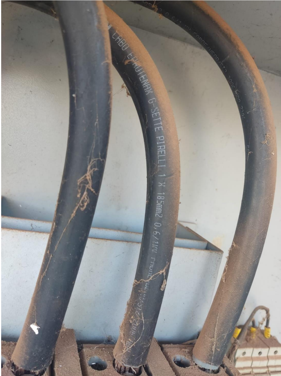
FIGURA 6 (BITOLA DO CABO DO DTM DO PADRÃO DE ENTRADA)
